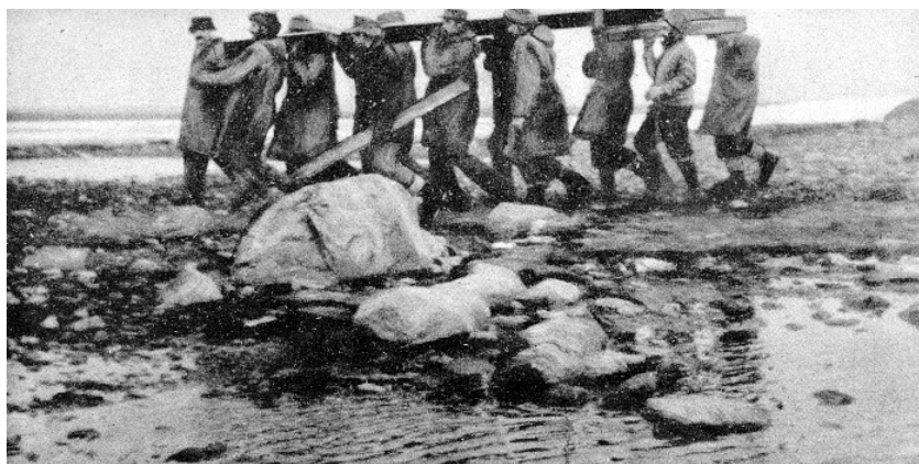
Figura 6. Primera etapa de la construcción de la primera cruz en el Territorio Chileno Antártico. Fuente: Terra Australis, Eugenio Orrego Vicuña (1948).
